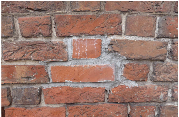
Fot.4 Wstawki nowych cegieł na zaprawach prawdopodobnie cementowych do usunięcia
