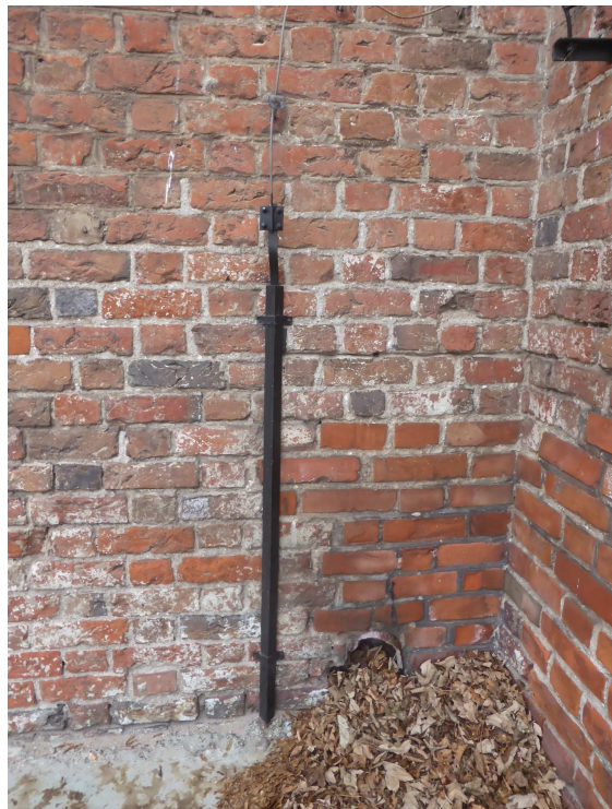
Fot.2 Narożnik skrzydła zamku i wieży – zanieczyszczenia odpływu
