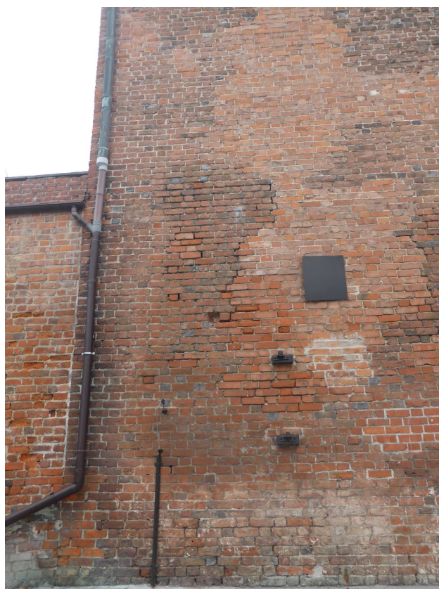
Fot.6 Duże ubytki w partii spoin, wstawki z nowych cegieł
