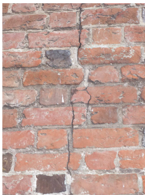
Fot.9 Pionowe spękania ściany do przeszycia
