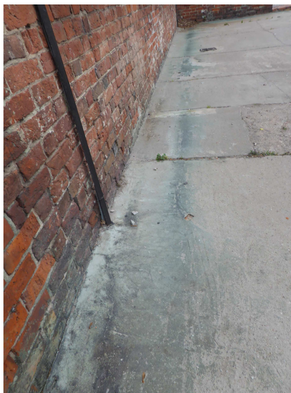
Fot.7 Wylewka betonowo przylegająca ściśle do muru skrzydła zamku
