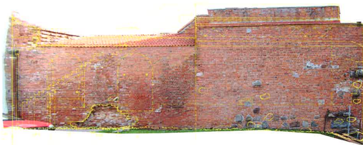
Rys. 19 Widok północnego muru kurtynowego i elewacji skrzydła zachodniego
