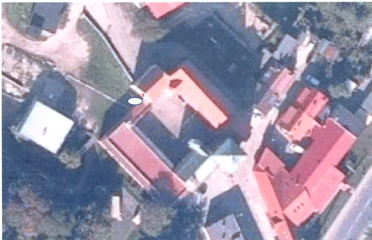
Rys. 4 ○ Lokalizacja awarii budowlanej Zamku Książąt Pomorskich w Darłowie (stan przed wykonaniem nawierzchni).
