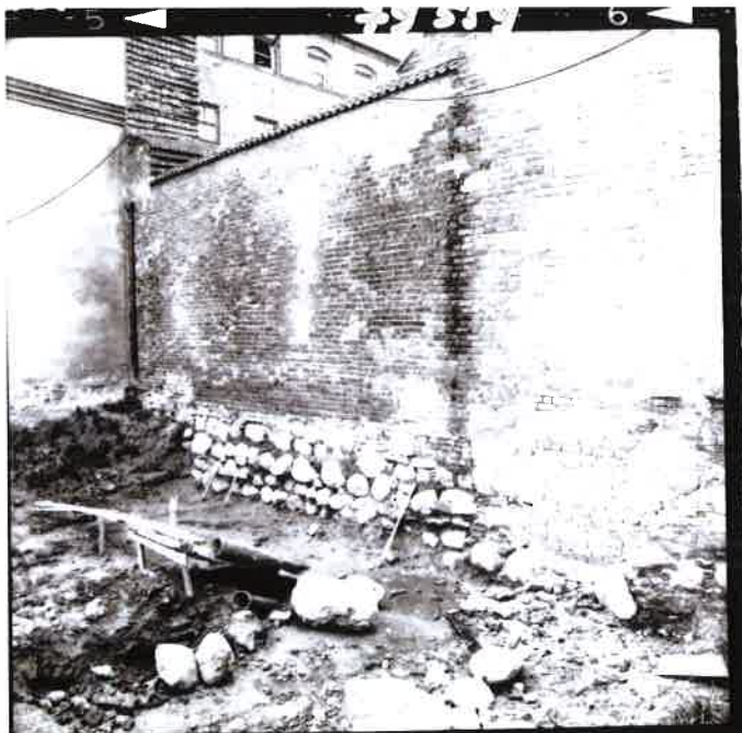
Rys. 6 Widok muru północnego w 1987 r.
