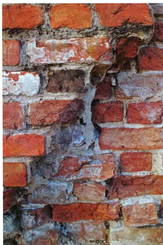
Rys.14 -15 Widok szczelin oddzielających warstwę licową od wnętrza muru
