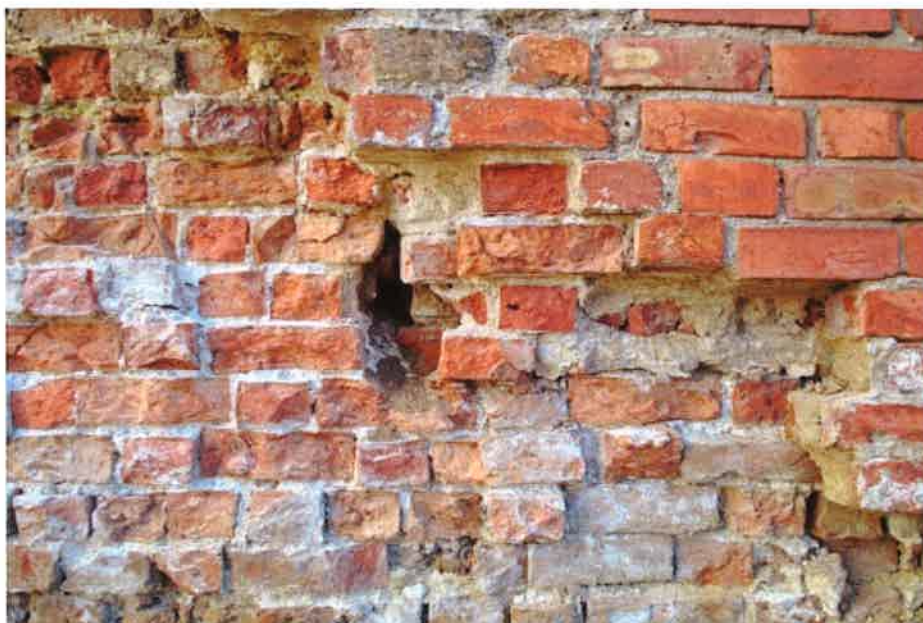
Rys. 13 Odkryty otwór w dolnym narożniku zamurowania otworu wejściowego.
