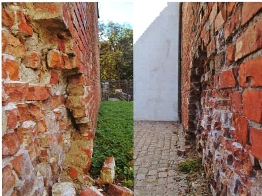
Rys.14 -15 Widok szczelin oddzielających warstwę licową od wnętrza muru
