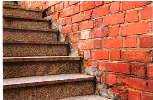
Rys. 10 Brak cokolika jako bariery dla wód opadowych
