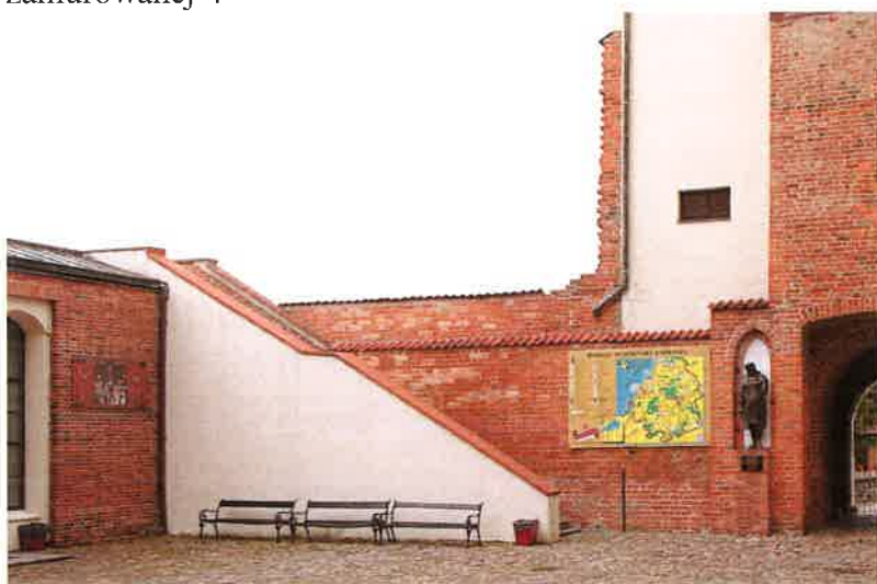
Rys. 7. Widok schodów na taras i lica muru północnego od strony dziedzińca.
